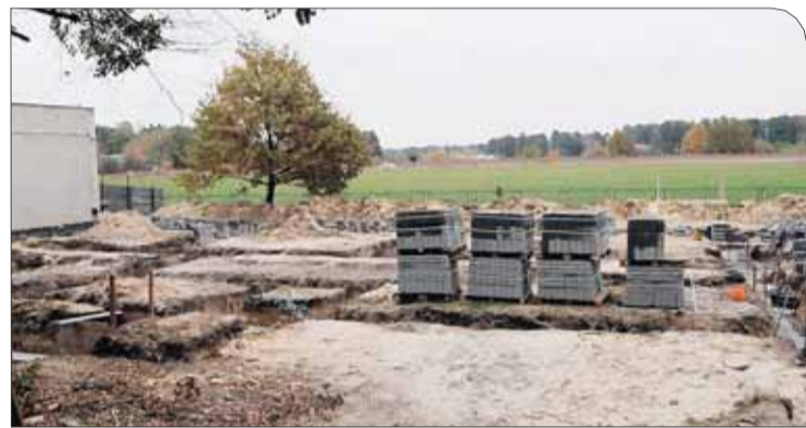
Budowa sali gimnastycznej w Józefowie
